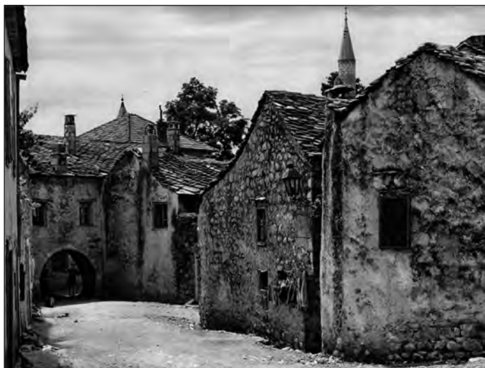
Slika 8. Pučko predgrađe Trebinja sa minaretom od kamena i karakterističnim krovovima od kamenih pločama (Hielscher 1926, str. 100).
